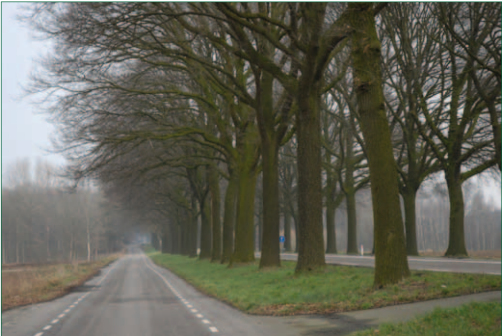
Il. 33: W wielu wypadkach skrajnię o wysokości 4,20 m można zapewnić dopiero wówczas, gdy wysokość wolnego od gałęzi pnia będzie wynosić 6 m
